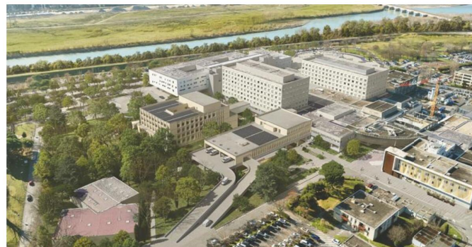
Le programme de modernisation Terrah 2030 vise à rendre le centre hospitalier d'Avignon plus attractif et plus accueillant pour tous. Photo Hôpital d'Avignon
