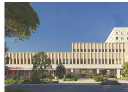
L'agrandissement et la restructuration des urgences adultes sont prévus pour 2032. Photo Hôpital d'Avignon
