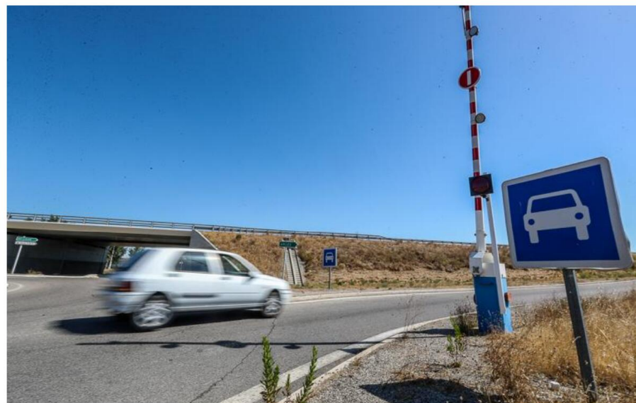
La première tranche de la LEO a été mise en service en 2010. Archives photo Christophe Agostinis
