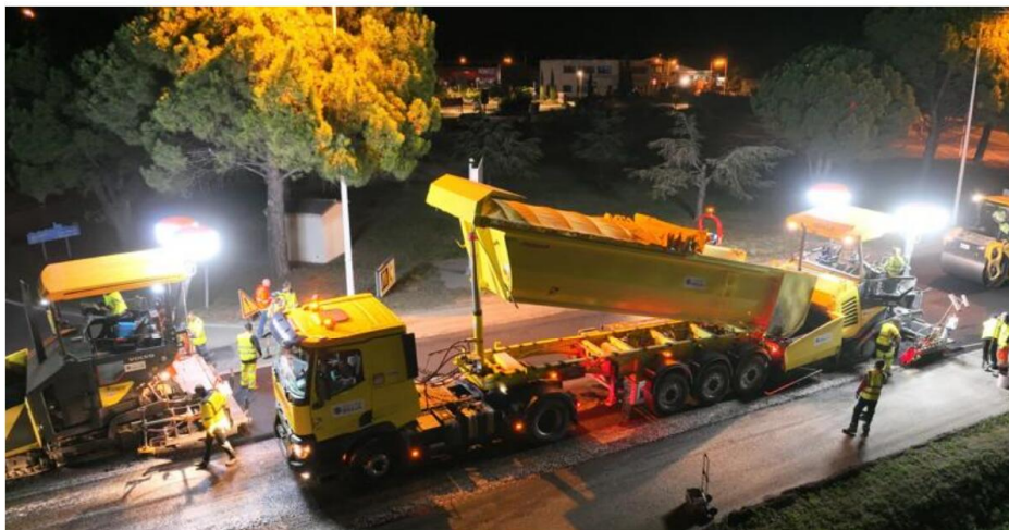
Des travaux réalisés par l'entreprise Braja-Vésigné au grand giratoire de Bollène, près du péage d'autoroute. Photo Groupe Braja Vésigné
